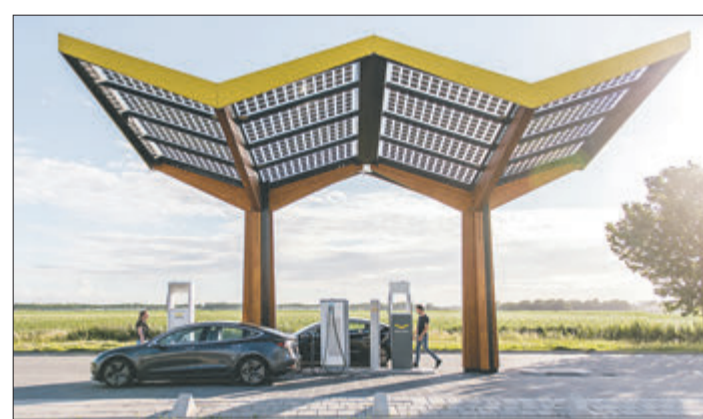
Über 1.000 Schnellladestationen, wie diese von Fastned, sollen in Deutschland an Autobahnen und Bundesstraßen bis 2024 entstehen. Das ambitionierte Vorhaben könnte jedoch schwieriger umzusetzen sein als gedacht. Foto: BS/Fastned
