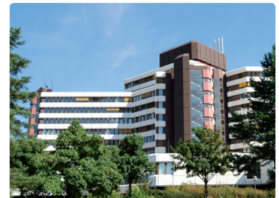
Das Dienstgebäude in Köln-Riehl
